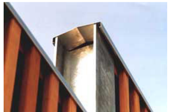
Titanzinkblechabdeckung, Schutz gegen Durchnässen
