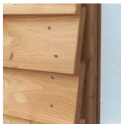
Stülpchalung, Lärche, Detail Gestaltungsvariante (ungeeignet für Schallschutz)
