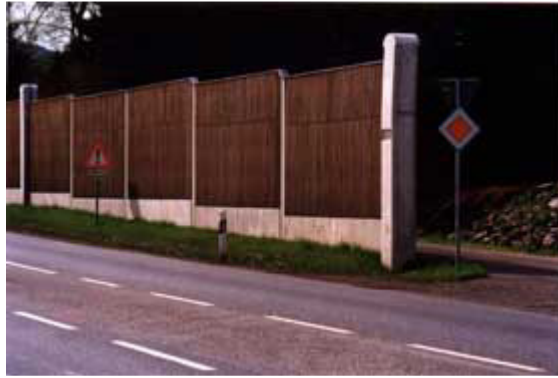
B 7 Helsa: Akazie/Robinia, hochabsorbierend, Betonstütze
