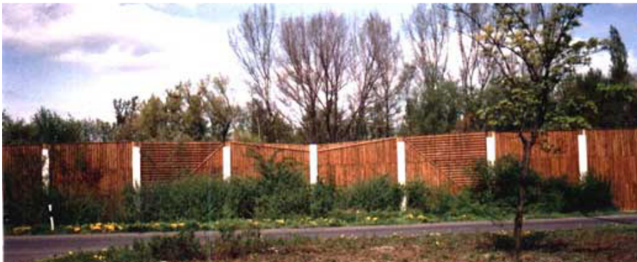
Lärmschutzwände aus Holz sind immer eine gute Wahl!
