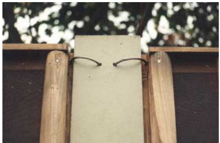
Fangseile aus Edelstahl, zusätzliche Sicherung auf Bauwerken
